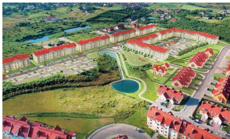
Osiedle Cztery Pory Roku - jedno z najciekawszych założeń urbanistycznych
