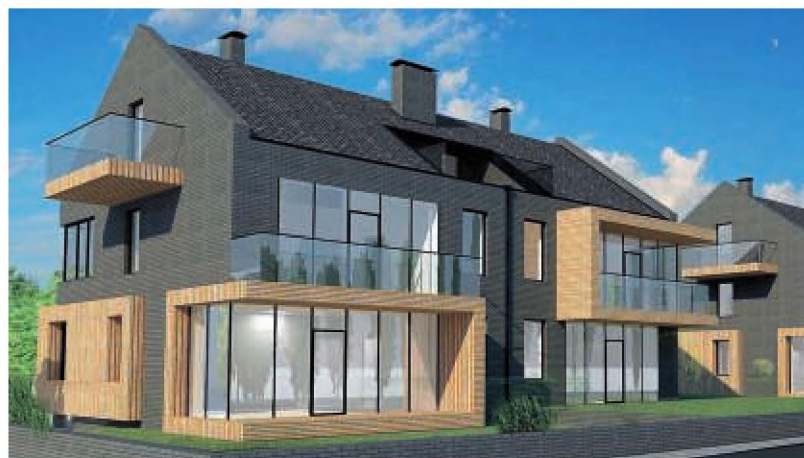
Kompleks apartamentowy przy ul. Polanki w Gdańsku Oliwie
