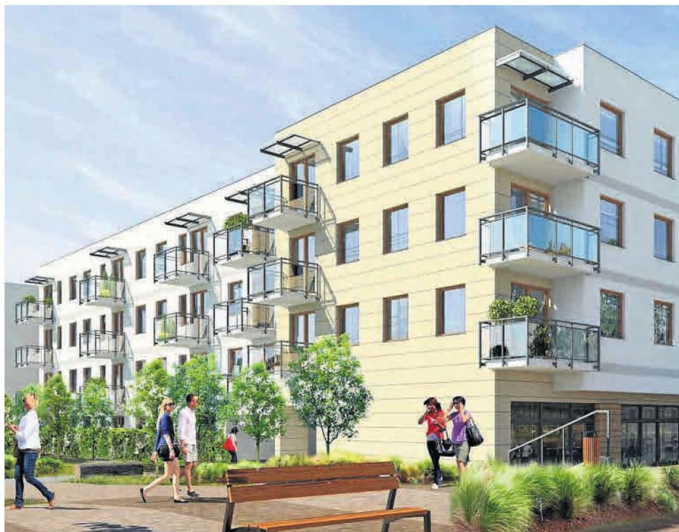
► W II kwartale br. ECO-Classic planuje rozpoczęcie budowy czwartego budynku ze 196 mieszkańami
