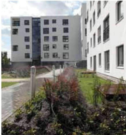
Górczewska Park (J.W. Construction Holding)
